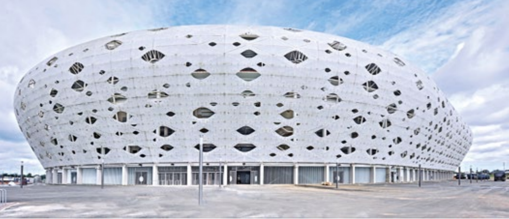
Moderne Eleganz und technische Finesse: das Godswill Akpabio International Stadium in Uyo, Nigeria, konzipiert von Julius Berger International
